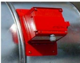
**Supporto per Montaggio per rivelatore di scintilla**
